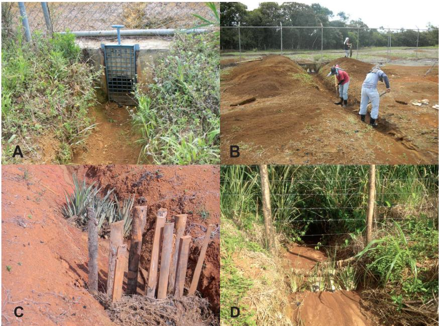
**Figura 13.** Tipos de barrera que se pueden implementar para prevenir la salida accidental de los OVMs por escorrentía fuera de las áreas aprobadas. A: Rejilla al final de un drenaje; B: Personal realizando labores de limpieza del drenaje y la rejilla; C: Vetiver recién sembrado al final de un drenaje; D: Estacas y controles de erosión (plantas no modificadas genéticamente).
